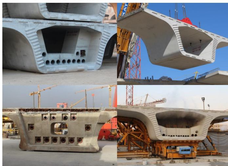
قطعات سگمنت تولید شده برای عرشه اصلی پروژه بزرگراه طبقاتی شهید صدر
