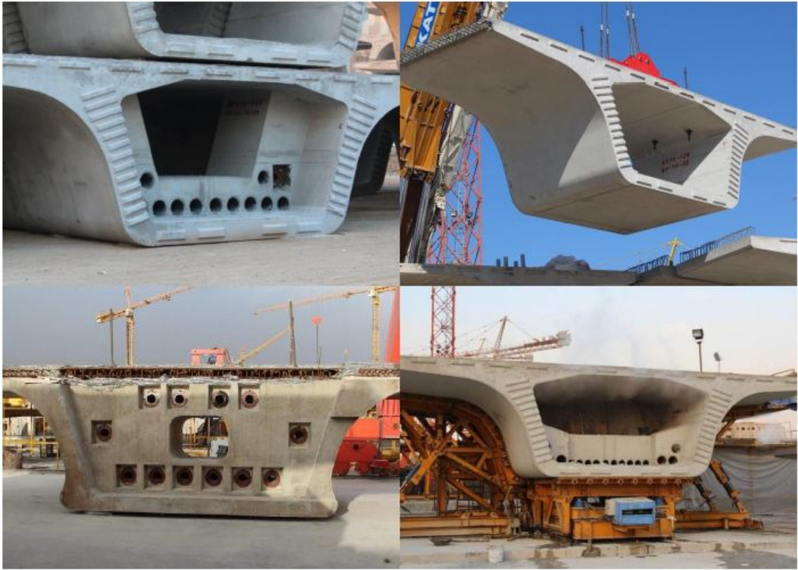
قطعات سنگمت تولید شده برای عرشه اصلی پروژه بزرگراه طبقاتی شهید صدر
